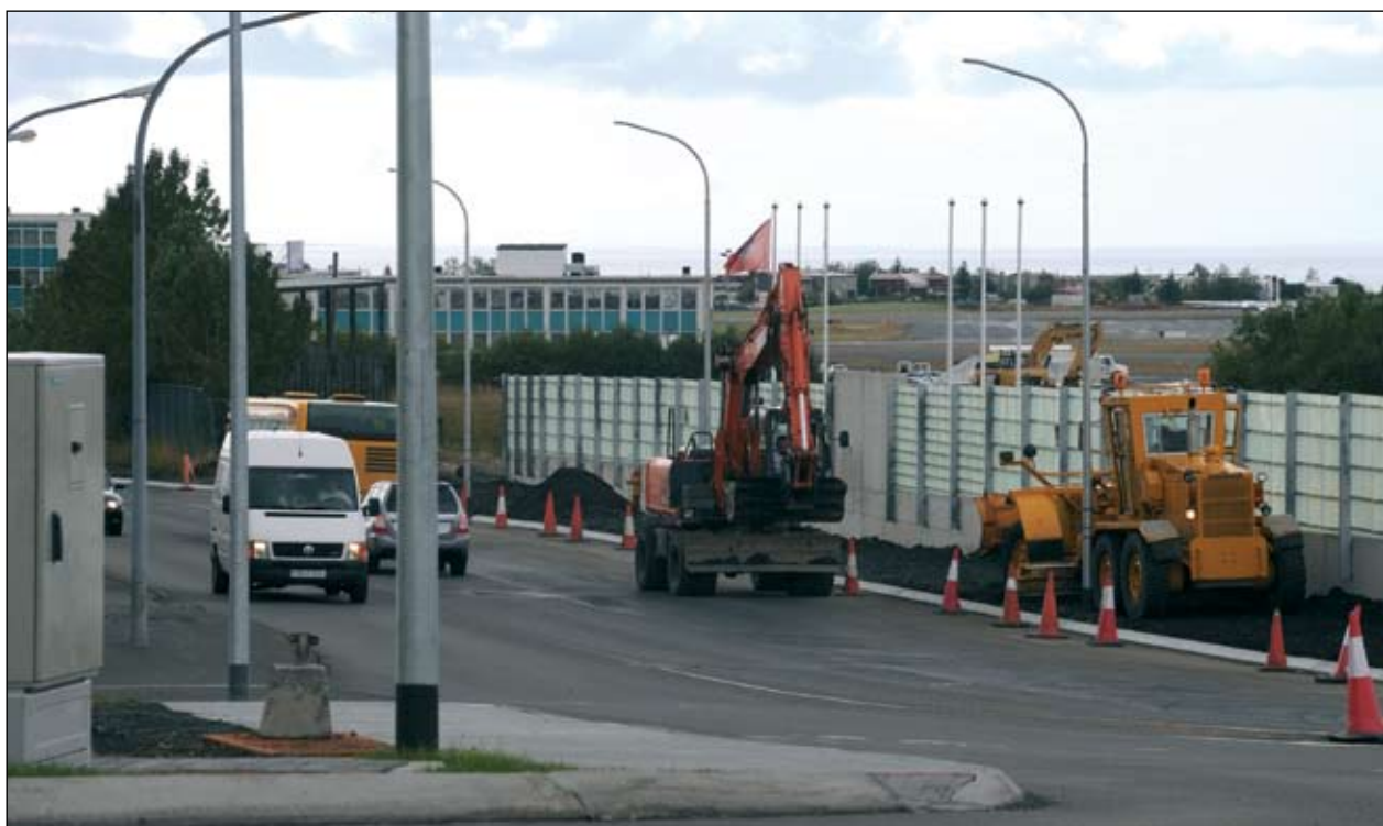
Bústaðavegur - Flugvallarvegur. Breytingarnar fela í sér tvöföldun vinstribeygju til suðurs inn á Flugvallarveg og breikkun Flugvallarvegar til að greiða fyrir umferð.
