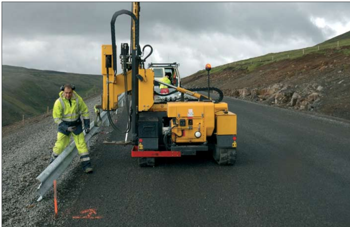
Hringvegur (1), Ármótasel - Skjöldólfsstaðir, 29. júlí 2009. Vegrið sett niður. Með þessum kafla er komið bundið slitlag á Hringveg (1) frá Reykjavík norður um til Egilsstaða.
